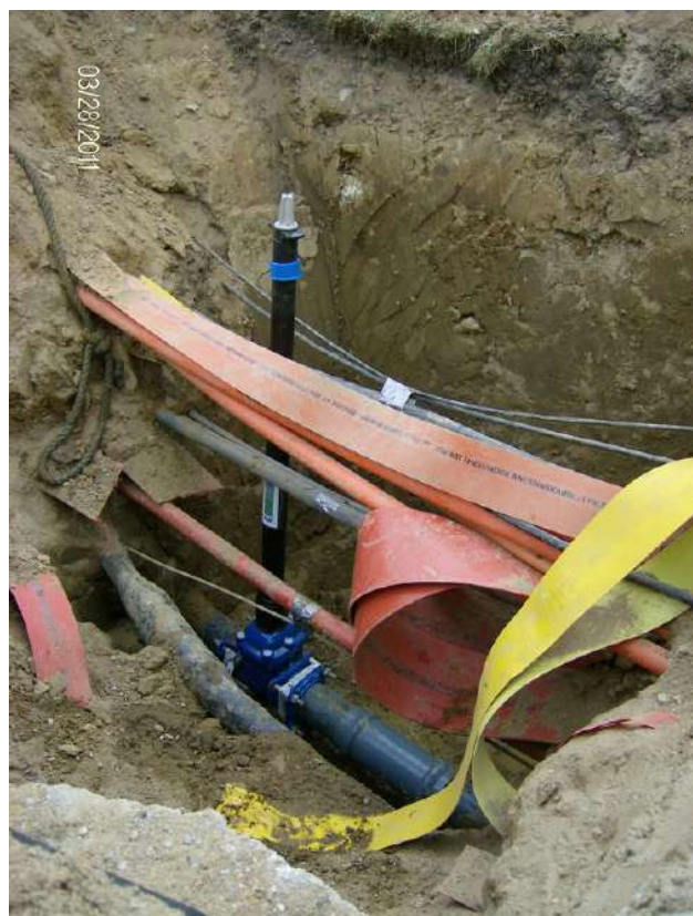
Besværligt gravearbejde for entreprenøren i 2012.
